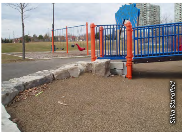
Utilisation d'un dénivellement plutôt que de rampes d'accès
